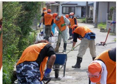
側溝のヘドロのかき出し
