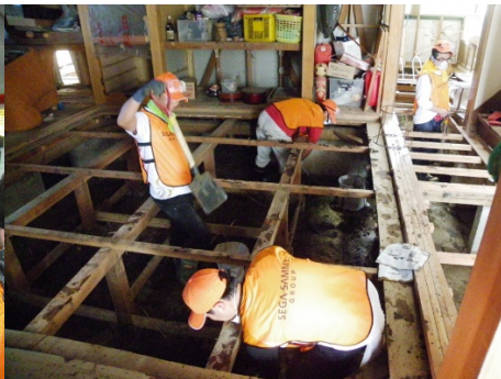
家屋の床下のヘドロのかき出し
